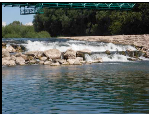
Photos 2 et 3 : Echancrure centrale
